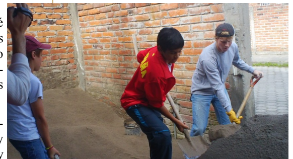
Anthony, Eduardo y Landon preparando mortero en el local de Ibarra, Ecuador .
